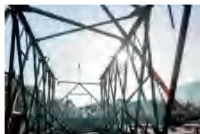
公司塔架试组装现场
